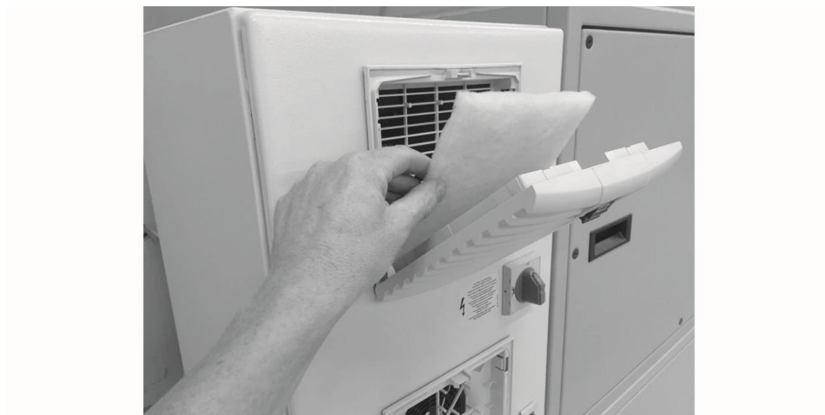
Fig. 39: Cambio del filtro del armario de distribución
